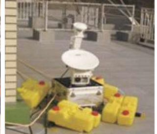
現地対策本部(釜石)に設置された可搬型USATの外観写真(アンテナ径45cm)
